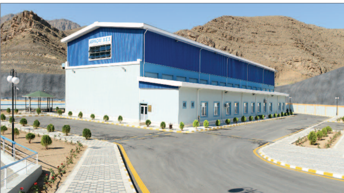
Şərur rayonunda 20,5 meqavat gücündə "Arpaçay-1" Su Elektrik Stansiyası
