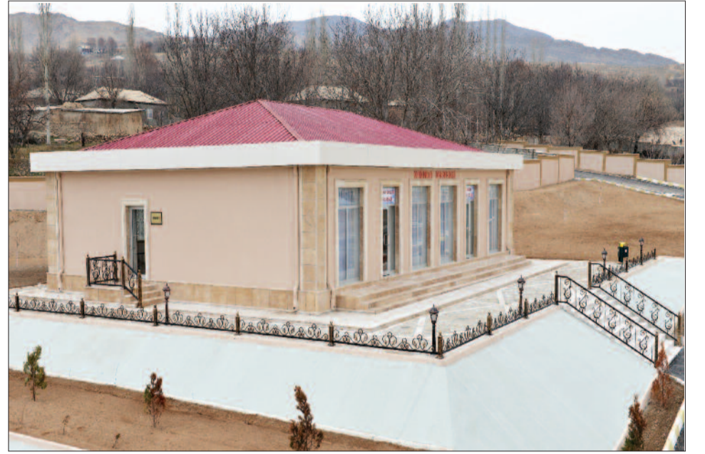
Kəngərli rayonunun Qarabağlar kəndində xidmət mərkəzi
