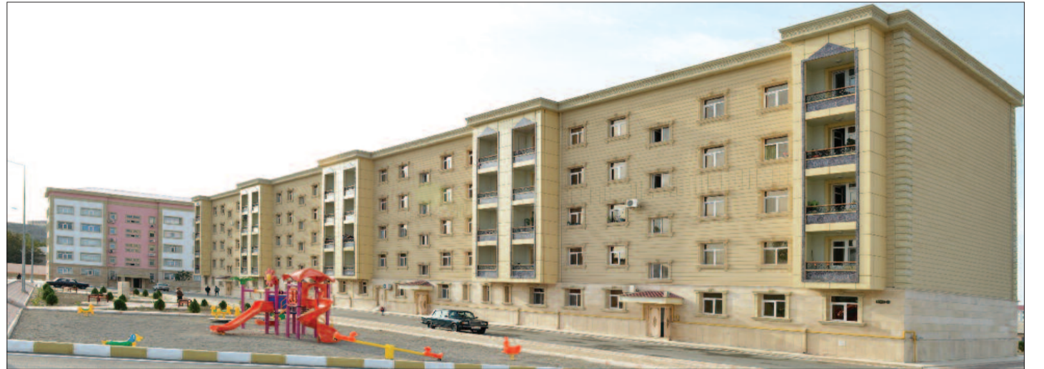
Naxçıvan şəhərinin Əliabad qəsəbəsində yaşayış binası
