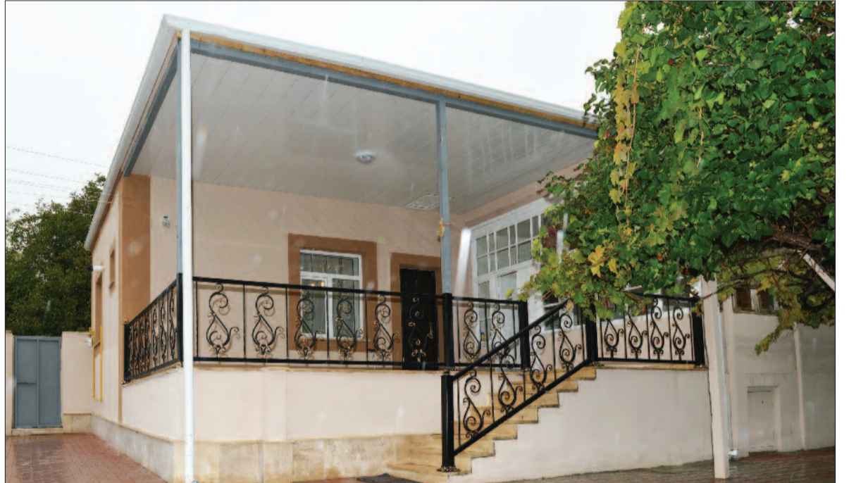
Şərur rayonunun Axura kəndində sosial qayğıya ehtiyacı olan ailə üçün fərdi ev
