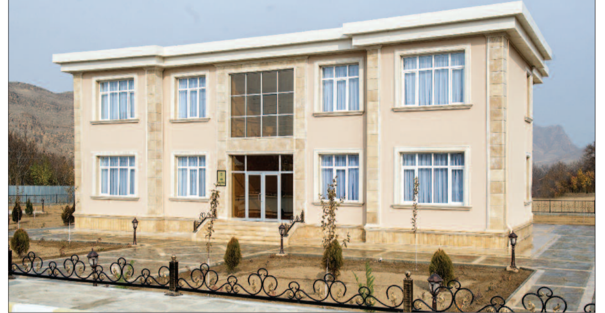
Şərur rayonunun Dizə kəndində həkim ambulatoriyası
