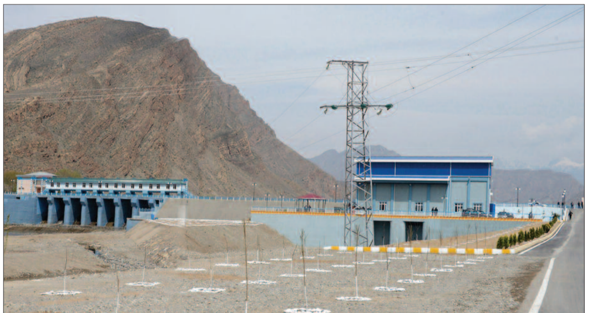
Şərur rayonunda 1,4 meqavat gücündə "Arpaçay-2" Su Elektrik Stansiyası
